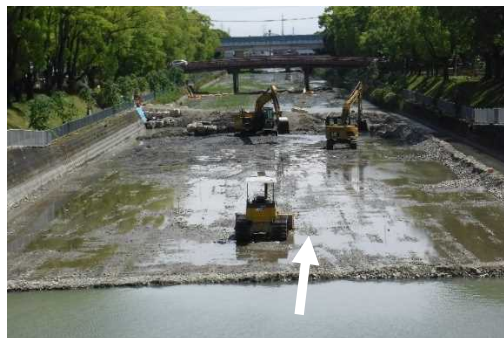
ヘドロ撤去の状況
