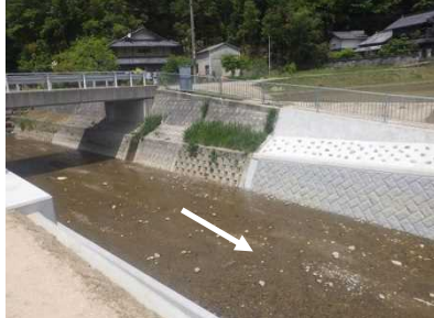
護岸・河床掘削
