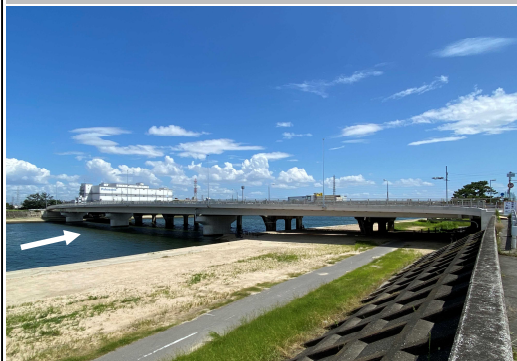
河床掘削に伴う南武橋架替
