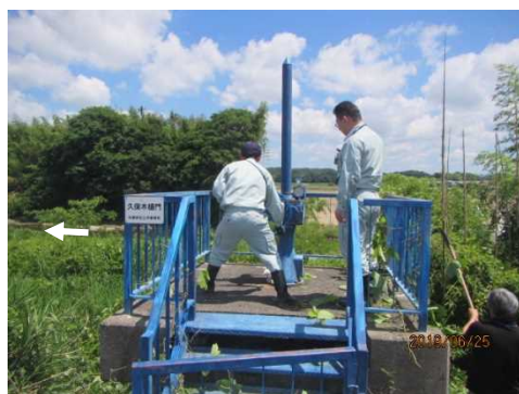
樋門点検 東条川(小野市)
