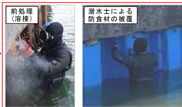
被覆防食の作業状況
