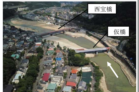
河床掘削に伴う西宝橋架替
