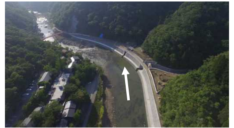
護岸・河床掘削
