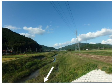
護岸・河床掘削
