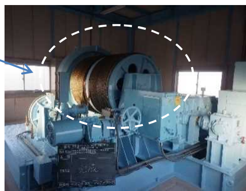
ゲート開閉装置取替
