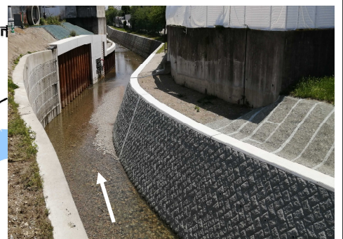
護岸・河床掘削
