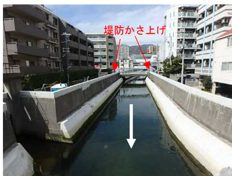
堤防かさ上げ 高橋川(神戸市)
