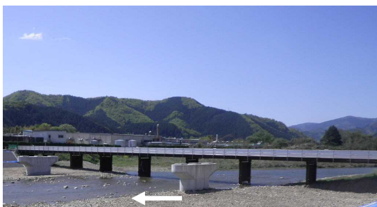
橋梁架替 円山川(朝来市)
