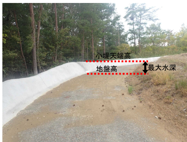
小堤の設置（モルタル吹付）（県立三田祥雲館高校）
