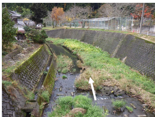
河床低下対策(根固工) 大山川(丹波篠山市)
