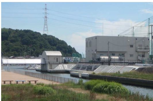
八家川排水機場（姫路市）
