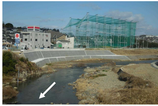
護岸整備 猪名川(川西市)
