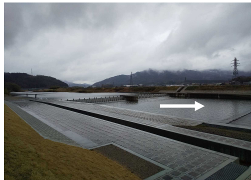
井堰改築 竹田川(丹波市)
