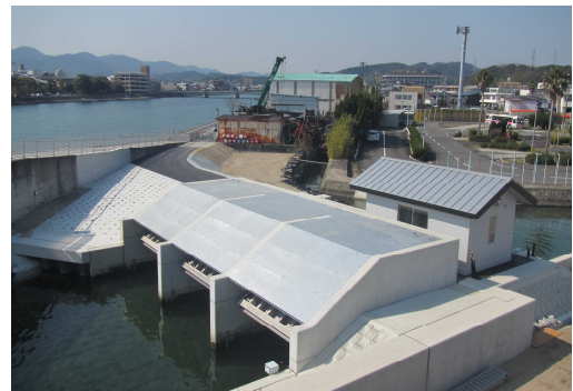
陀仏川樋門（洲本市）
