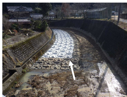
河床低下対策(根固工) 大山川(丹波篠山市)
