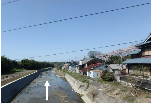
河道拡幅 おうごがわ 淡河川(神戸市)
