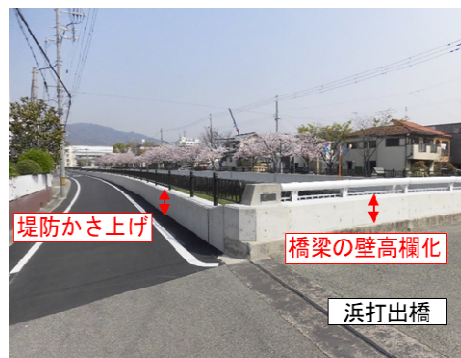
堤防かさ上げ 宮川(芦屋市)
