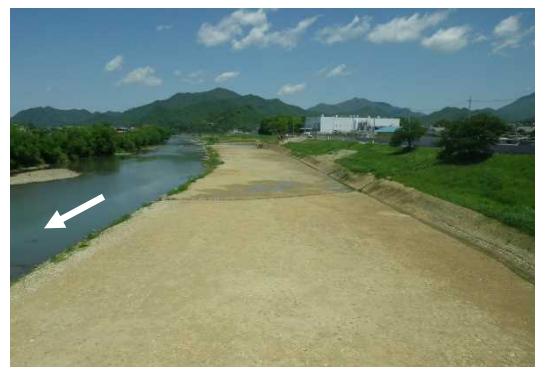
河床掘削 加古川(西脇市)
