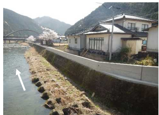
堤防かさ上げ おおやがわ 大屋川(養父市)
