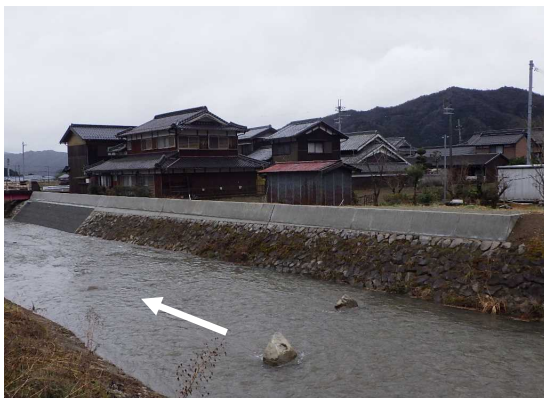
堤防かさ上げ おくあらたがわ 奥荒田川(多可町)
