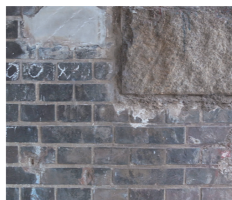
16 庄堺架道橋 旧神戸臨港線遊歩道
