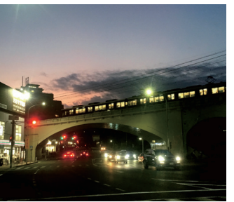
9 銀河鉄道の夜 阪急王子公園駅高架橋
