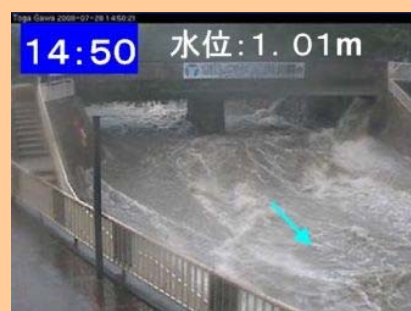
平成20年7月28日 都賀川(甲橋) 水位上昇状況
