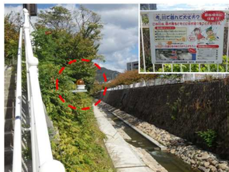
増水警報装置（妙法寺川）
