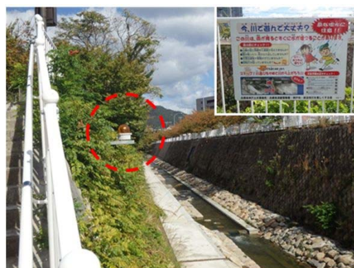
増水警報装置（妙法寺川）
