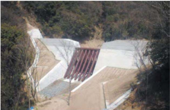
砂防えん堤の整備事例
