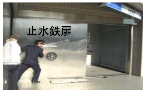
止水板、止水鉄扉（神戸市営地下鉄）
