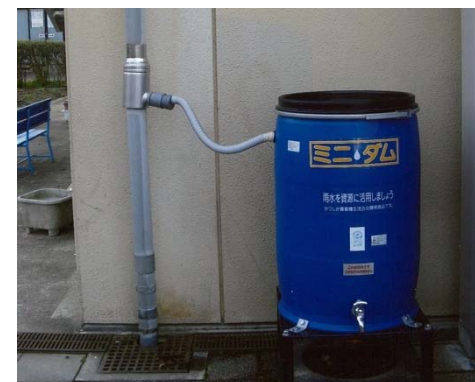
雨水貯留タンク
