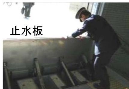
止水板、止水鉄扉（神戸市営地下鉄）
