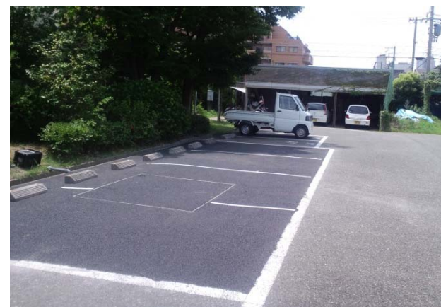
駐車場透水性舗装の例 (兵庫県西神戸庁舎)
