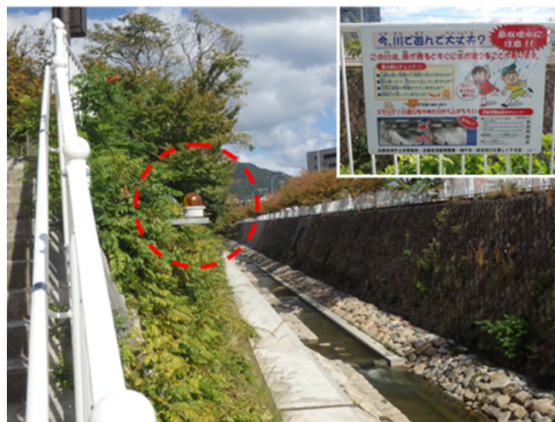
増水警報装置(妙法寺川)
