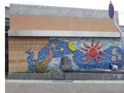
河川防災ステーション(新湊川)
