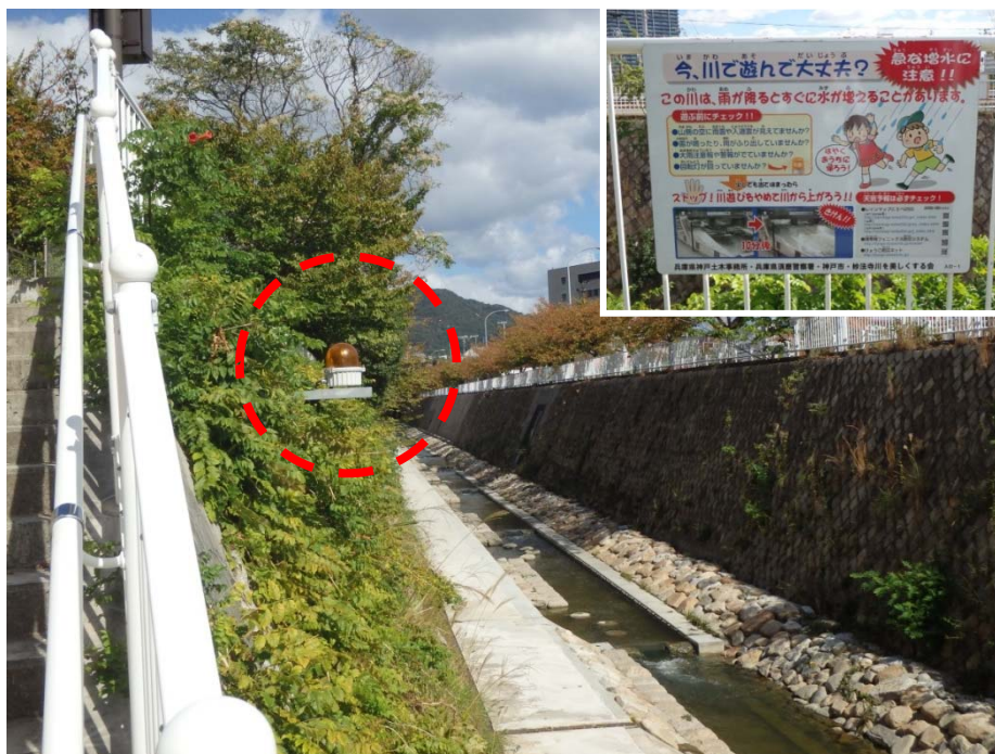
図 7.2.1 回転灯の設置（妙法寺川）
