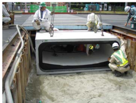
図 5.2.3 雨水幹線の整備（神戸アクアプラン 2015）
