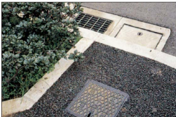
道路面の雨水を集めて浸透させます
