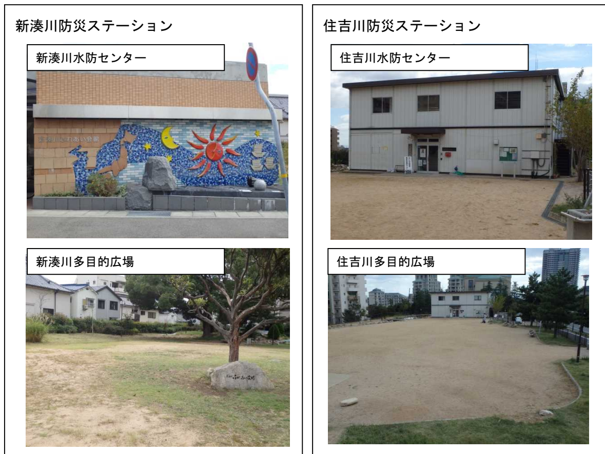
図 7.2.19 河川防災ステーション
