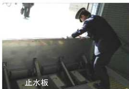
図 7.4.1 止水板、止水鉄扉の設置（神戸市営地下鉄）
