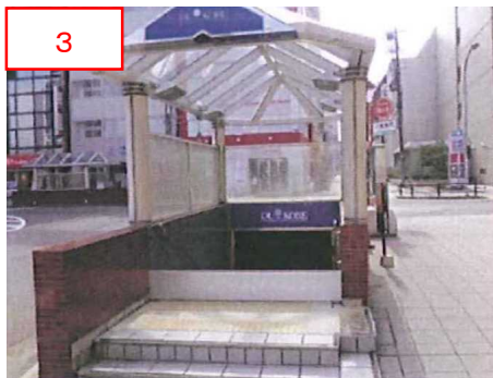
図 7.4.2 止水板の設置 (デュオこうべ)
