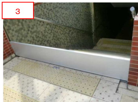
図 7.4.2 止水板の設置 (デュオこうべ)
