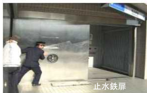
図 7.4.1 止水板、止水鉄扉の設置（神戸市営地下鉄）
