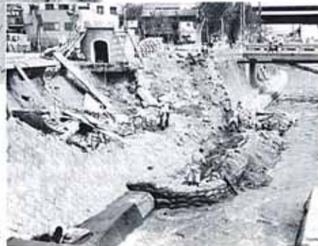
阪神大石駅付近
