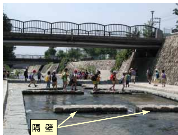
魚道用の隔壁のおかげで水が貯まりやすい
