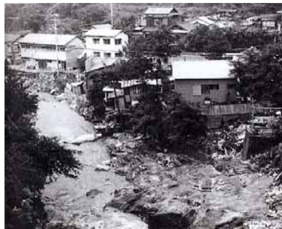
氾濫した天王谷川（神戸市兵庫区）
