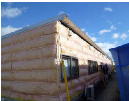
巨理町公共ゾーン仮設住宅
