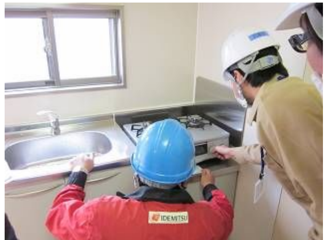
応急仮設住宅完了検査立会
