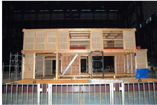
(c) 鉛直フレーム型アウターフレーム（リングダンパー）の設置状況：九通り
