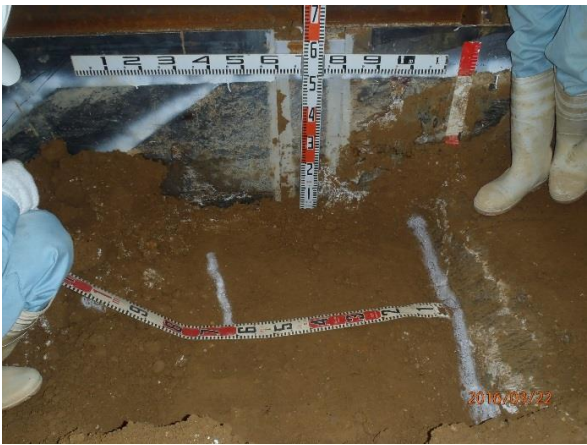
写真 28 シート側天端石灰到達状況(2)
