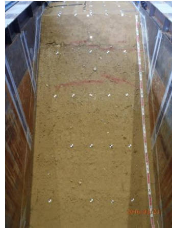
写真 21 前刃金上流法面クラック発生状況
