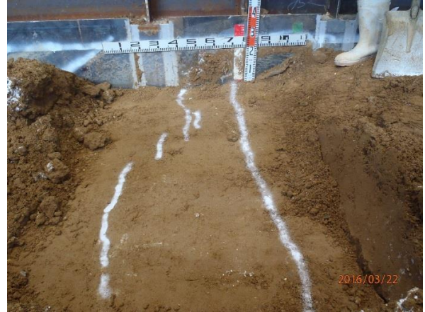
写真 27 シート側天端北側石灰到達状況(1)
