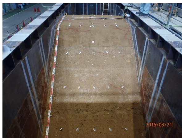
写真 25 シート側上流法面クラック発生状況
