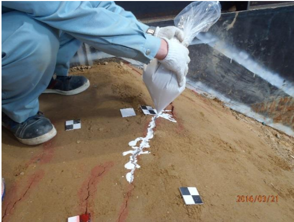
写真 20 石灰の流し込み状況
