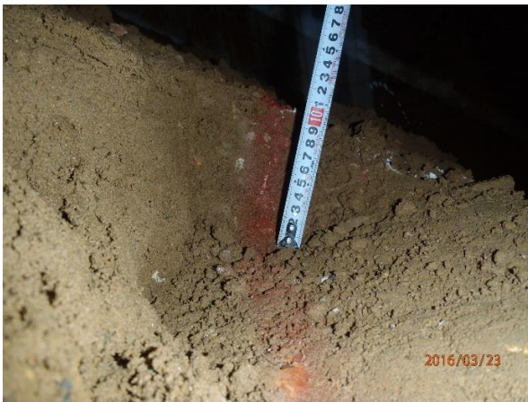
写真 22 前刃金上流法面クラック深さ測定状況
