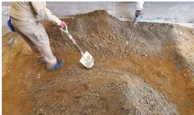
写真 5-8 盛土の天端の様子
