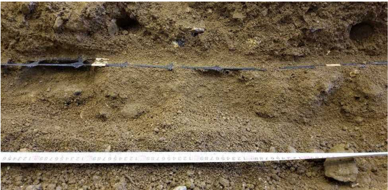
写真 5-14 2 番目のジオグリッドの様子(拡大写真)(2 段タイプ側)
