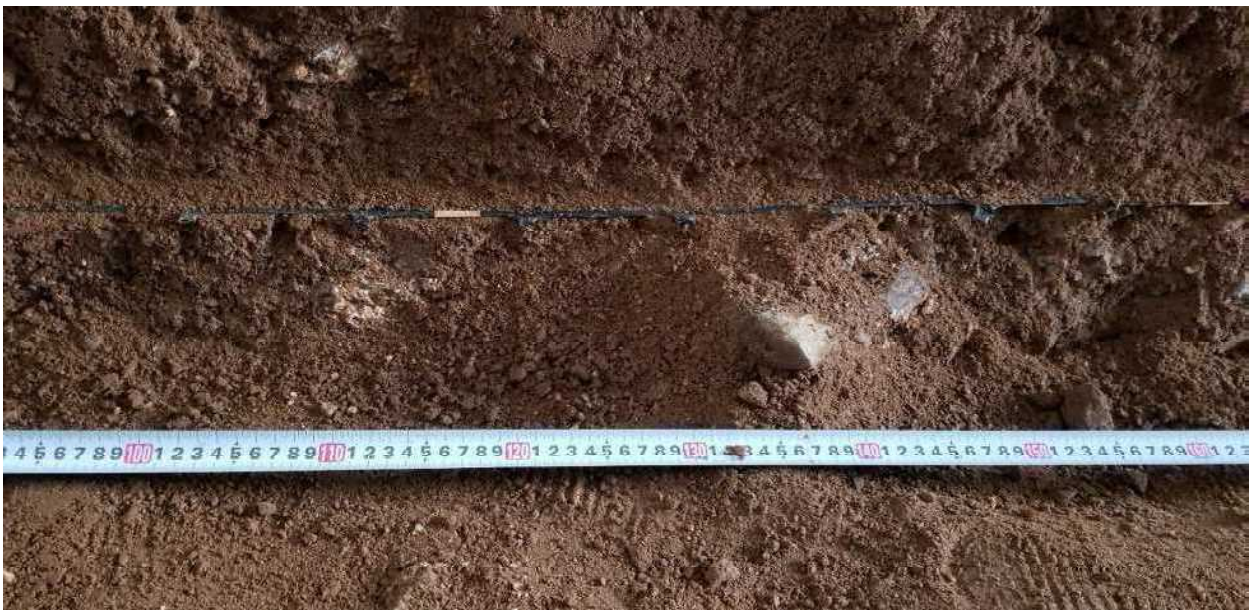
写真 5-12 2 番目のジオグリッドの様子(拡大写真)(1 段タイプ側)
