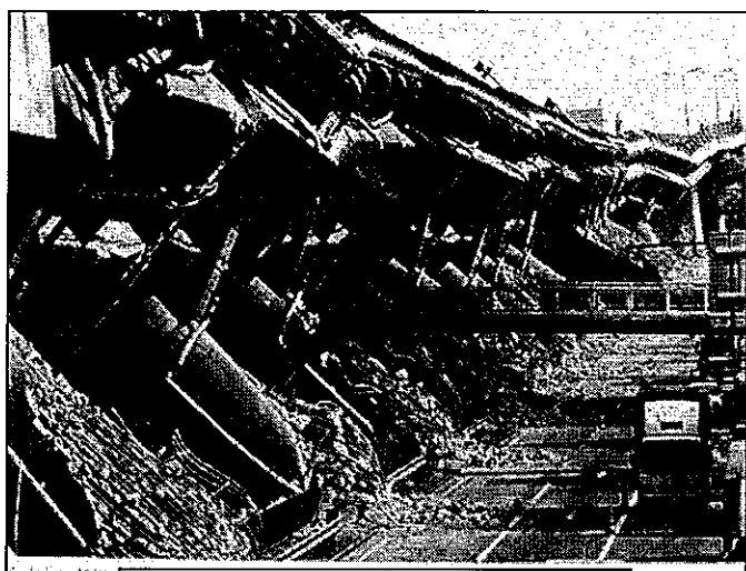
倒壊した阪神高速道路神戸線（神戸市）
