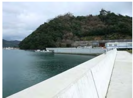
写真 5.1 防潮堤整備(福良港)
