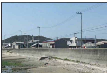
写真 6.3 防潮堤 (着工前)
