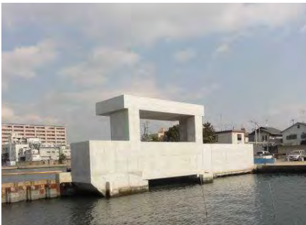
写真 5.12 洗戎川水門(事業中)
