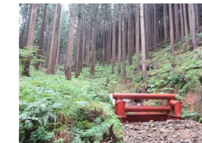
【流木止め施設整備(丹波市)】
