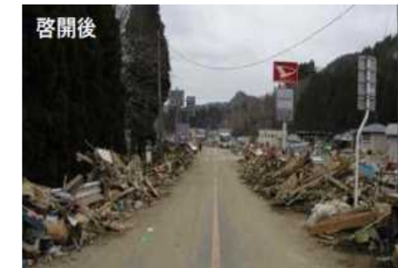
【道路啓開状況（岩手県宮古市田老地区）】
