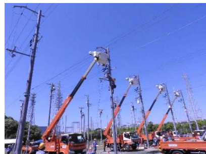
【関西電力(株)の訓練の様子①】
