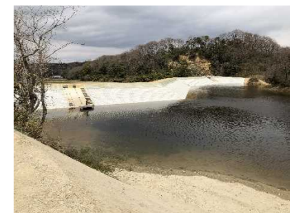
【清水谷池(神戸市西区押部谷町)】
