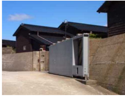
【陸閘(香美町無南垣)】
