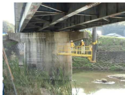
【橋梁下面の点検の様子】
