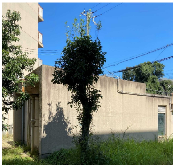
＜ポンプ室（新設分）＞
