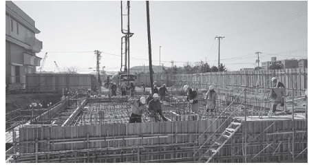
写真 99 公共下水道施設の建設支援（淡路市津名浄化センター）
