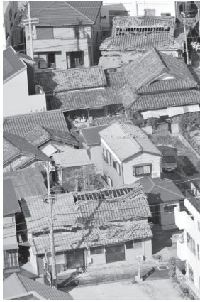
写真 30 淡路島地震による住家被害（洲本市）（共同通信社提供）
