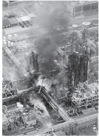
写真 32 日本触媒姫路製造所爆発火災事故(共同通信社提供)
