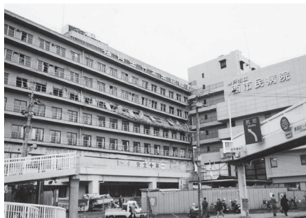
写真 147 被災した神戸市立西市民病院（人と防災未来センター提供）
