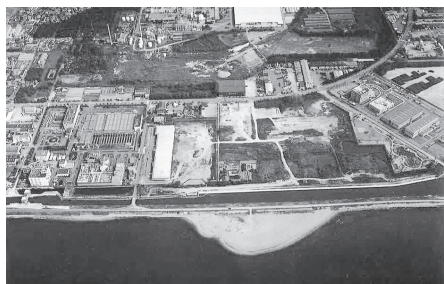
写真 77 加古川流域下水道 (下流処理場)
