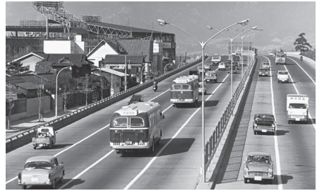
写真 66 開通直後（昭和 38 年頃）の国道 43 号（西宮市提供）
