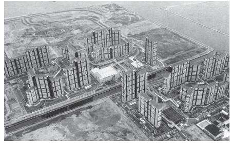
写真 64 建設途上の芦屋浜シーサイドタウン
