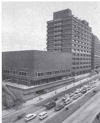
写真16 新築された兵庫県第二庁舎（昭和46年）
