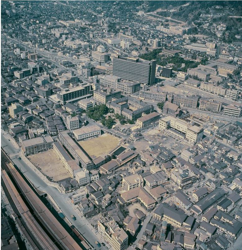
兵庫県庁・国鉄元町駅付近 (昭和 42 年頃)
