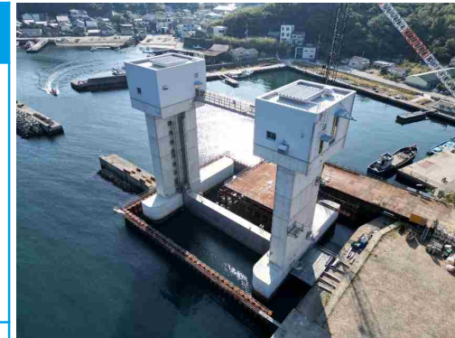
沼島漁港 水門整備
