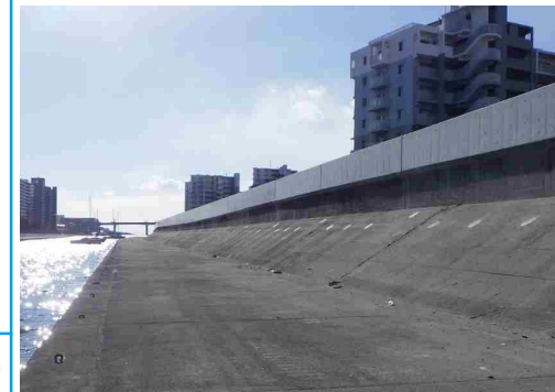
尼崎西宮芦屋港海岸 高潮対策(防潮堤嵩上げ)
