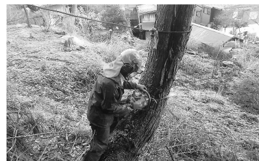
人家裏の危険木伐採
