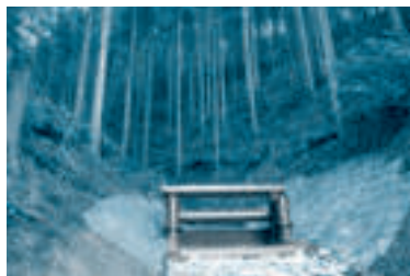
簡易流木止め施設
