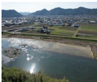
加古川 河床掘削 (西脇市)
