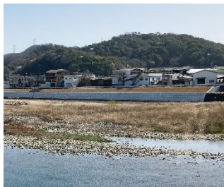
市川 護岸工事 (姫路市)
