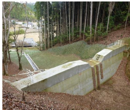
治山ダム (丹波篠山市)
