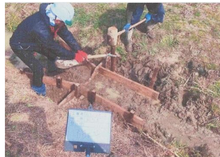
皿池用水路 ビオトープ整備 (高砂市)
