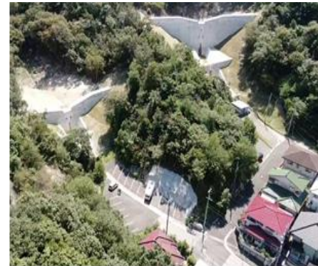
砂防堰堤 (相生市)
