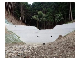
治山ダムの整備
