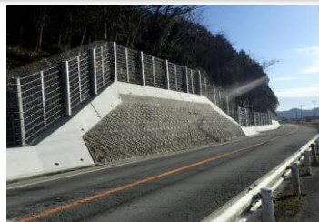
国道373号 落石防護柵(上郡町)
