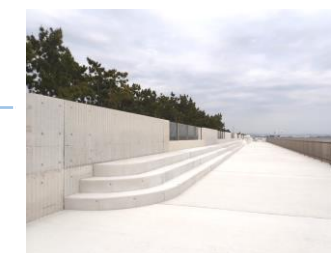
尼崎西宮芦屋港海岸 高潮対策(防潮堤嵩上げ)
