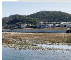
市川 護岸工事(姫路市)
