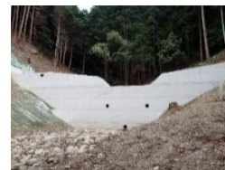
治山ダムの整備
