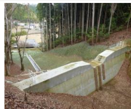
治山ダム(丹波篠山市)
