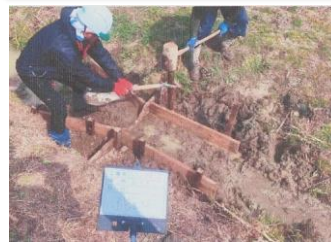
皿池用水路ビオトープ整備(高砂市)
