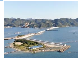
福良港 湾口防波堤
