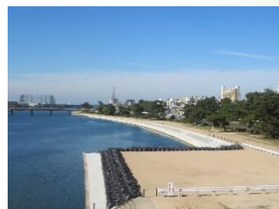
治水対策の推進（河川改修）
