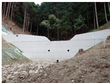
土砂災害防止施設（治山ダム）の整備
