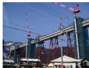
【余部橋梁の工事の様子】
