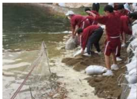
相生湾に砂を投入し、干潟を再生 (相生市・相生湾自然再生学習会議)
