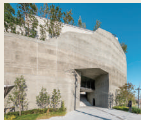
「神戸ポートミュージアム」の外観
