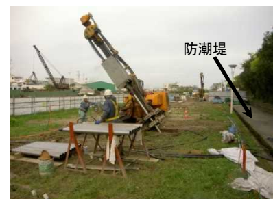
防潮堤の沈下対策の実施状況(尼崎市)
