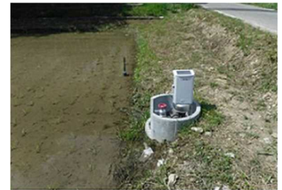
用水路のパイプライン化
