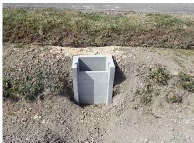
一筆排水柵の設置
