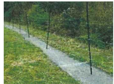
鉄鋼スラグ材の敷設例
