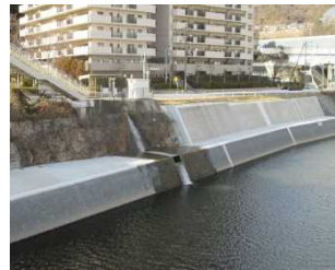
(二) 武庫川 (西宮市生瀬) 護岸整備
