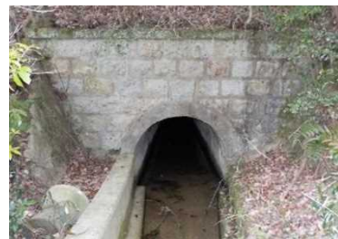
水路トンネル
