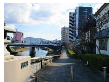
市道相生橋浄水線と武庫川(現況)
