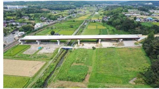
(主) 三田西インター線(三田市溝口～長坂) バイパス工事
