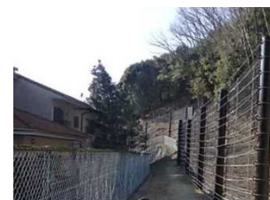
急傾斜地崩壊対策 (猪名川町伏見台)
