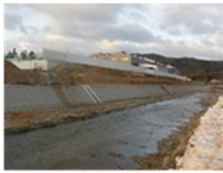
(一) 猪名川 (川西市矢間) 護岸整備
