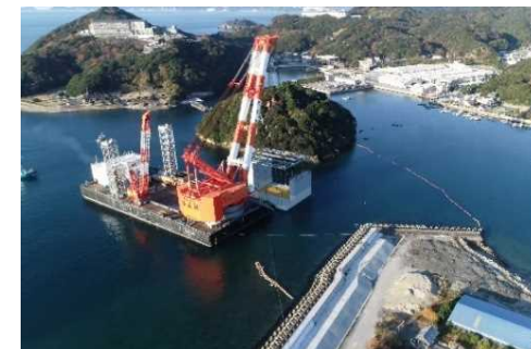
福良港 湾口防波堤
