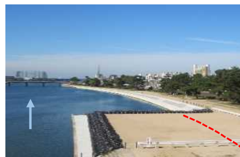
武庫川の河川改修 (赤点線：改修後の護岸の位置)
