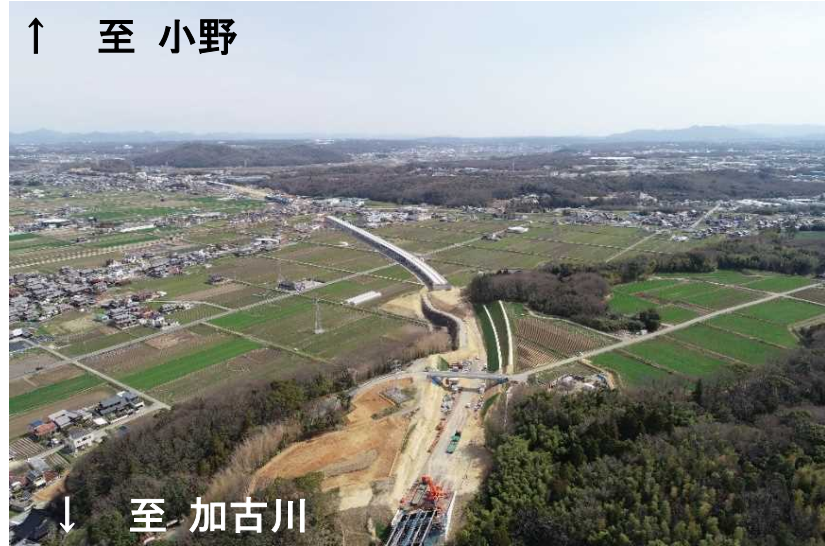
下村高架橋（加古川市）
