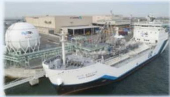
液化水素運搬船 液化水素タンク
