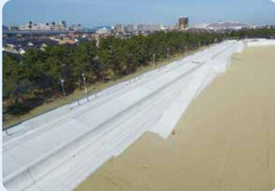
ビーチ護岸・南護岸の防潮堤は、海側の中壁と陸側の後壁の2段構造とすることで防潮堤の高さを抑えられました。また、後壁にはアクリルパネルを採用するなど、防災機能を担保しつつも、眺望や景観に配慮しています。
