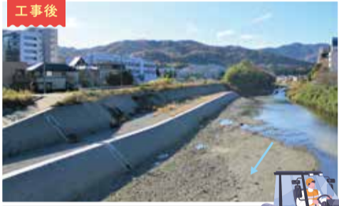
猪名川河川改修の状況(川西市)
