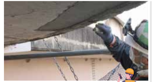
宝塚大橋の補修状況(宝塚市)
