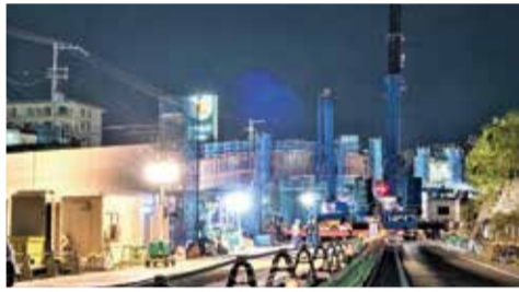
宝塚IC出入り口付近の工事状況(宝塚市)
