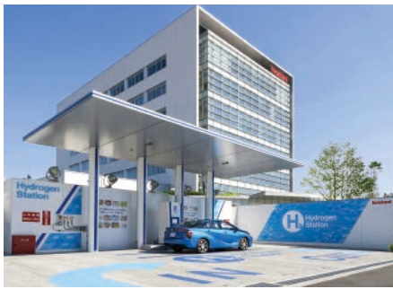
水素ステーション（尼崎市） 岩谷産業株式会社提供
