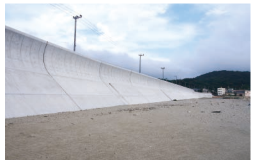
阿万港で進む防潮堤の整備（南あわじ市）
