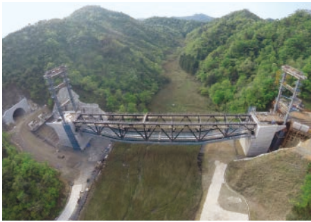
整備が進む山陰近畿自動車道（浜坂道路）
