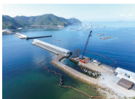
福良港の湾口防波堤 (南あわじ市)
